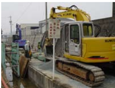
機械を使った掘削工事(岩屋地区内)
